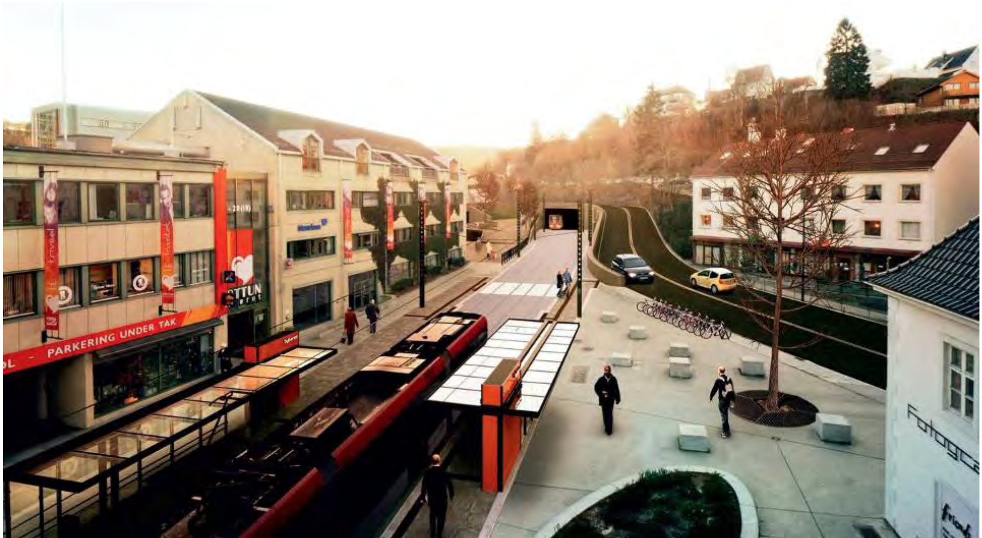
1. Holdeplass på byggetrinn 2, ferdig sommeren 2013
